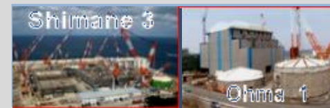
JAPÃO: 2 Usinas em Construção
