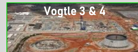
EUA: 2 Usinas em Construção
