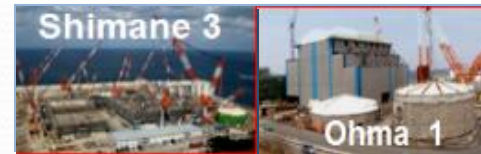
JAPÃO: 2 Usinas em Construção
