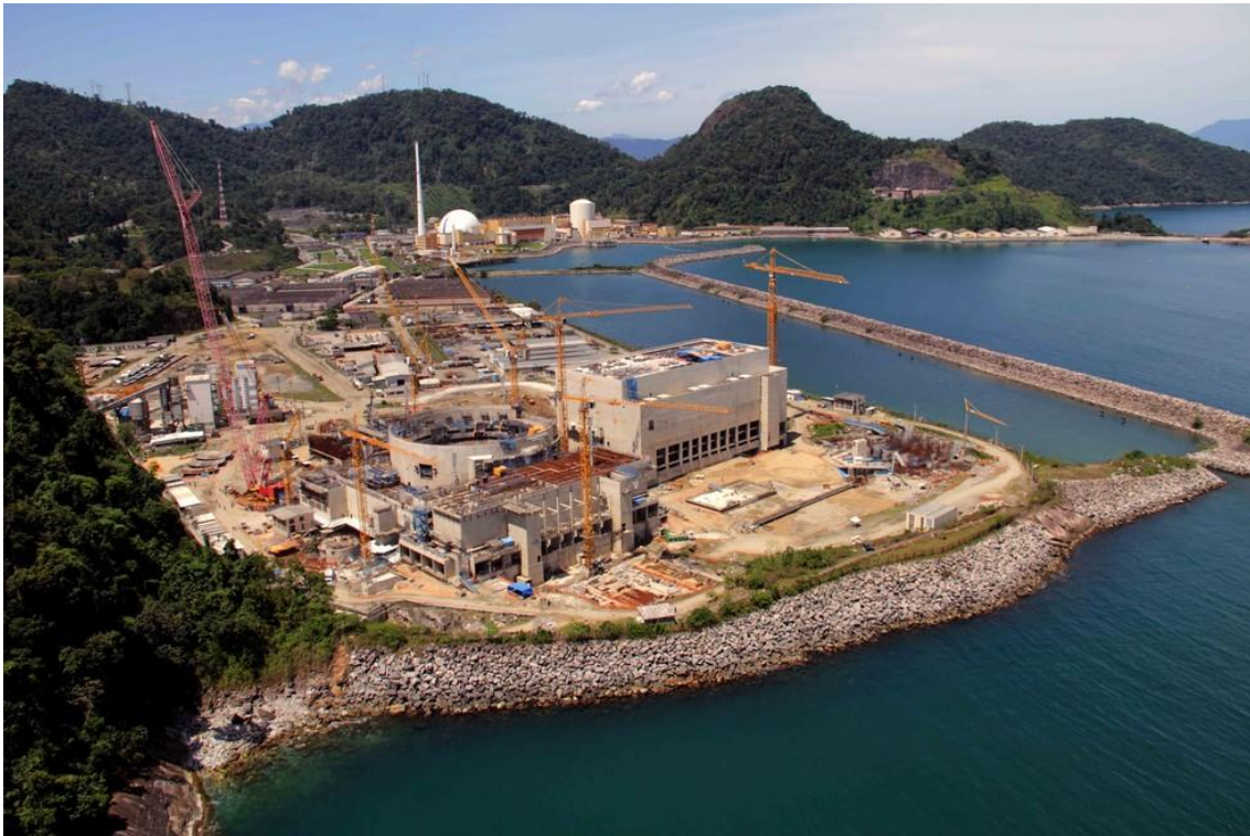
Obras de Angra 3: marcadas por escândalo de corrupção, obras se arrastam desde 1984. — Foto: Divulgação Eletronuclear
