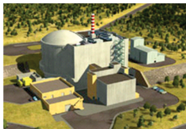
Reator JULES HOROWITZ França (em construção)
