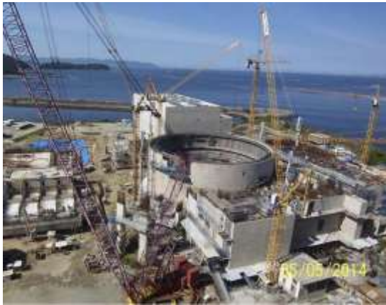
Fig. 37 - Obra de Angra 3
