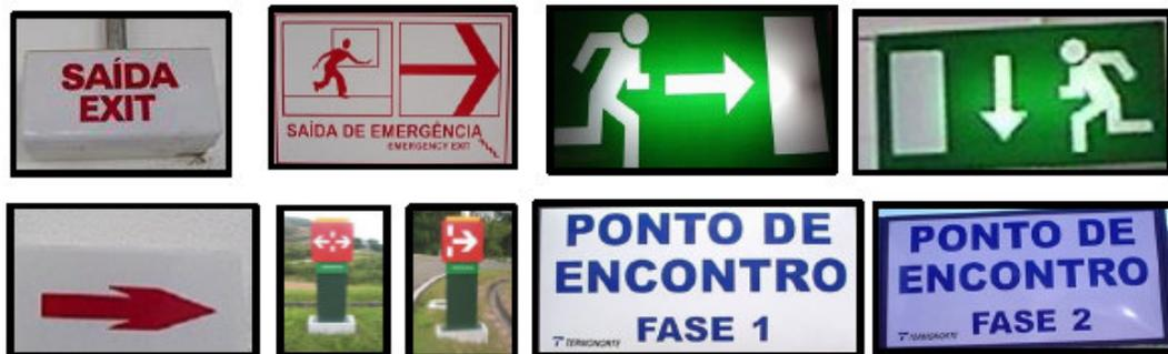
Figura 43 - Exemplos de placas de sinalização de rotas de fuga.
