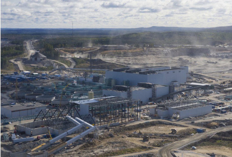
FIG. A-6. Talvivaara uranium project, Finland.
