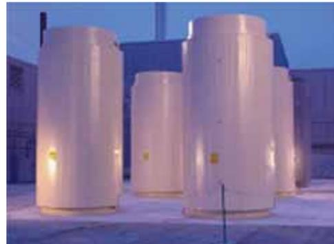
Exemplo de armazenamento a seco (Holtec International Co)
