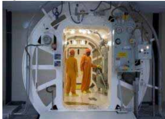
Técnicos em inspeção no edifício do reator de Angra 2
