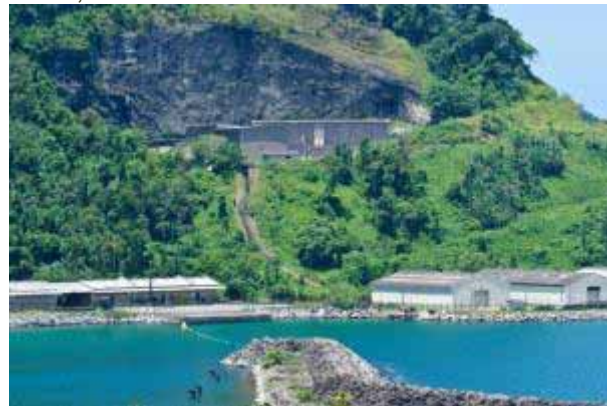
Centro de Gerenciamento de Rejeitos – Média e baixa atividade
