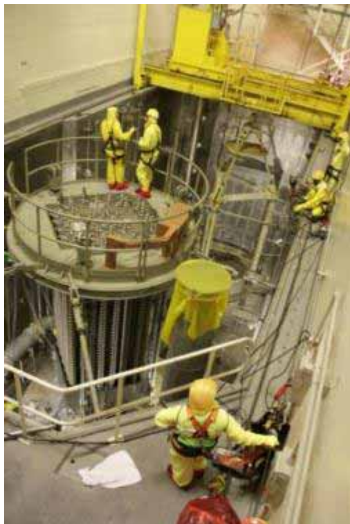
Reator de Angra 1 durante troca do combustível
