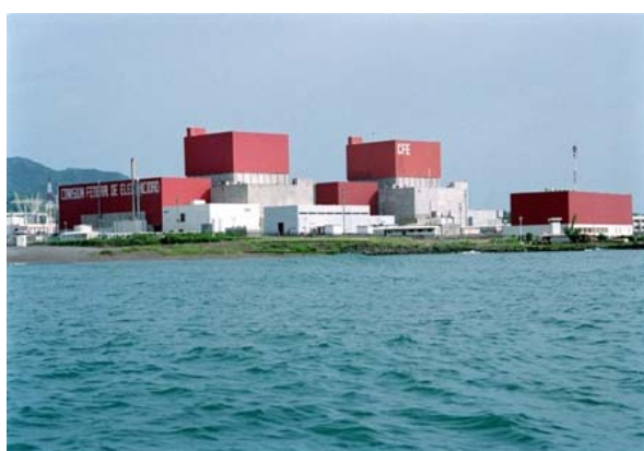
Laguna Verde – Mexico (Image Comision Federal de Electricidad -CFE)
