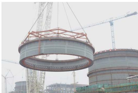
Haiyang 2 (AP-1000) – maio 2012 (photo CNECC)
