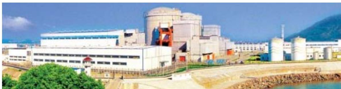
Qinshan 4 Fase II em operação comercial desde 2012
