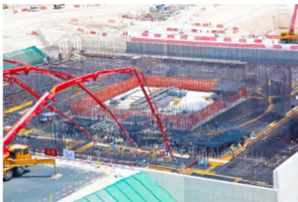
Construção de Barakah 1 nos Emirados Árabes - UEA (Foto cortesia da ENEC)
