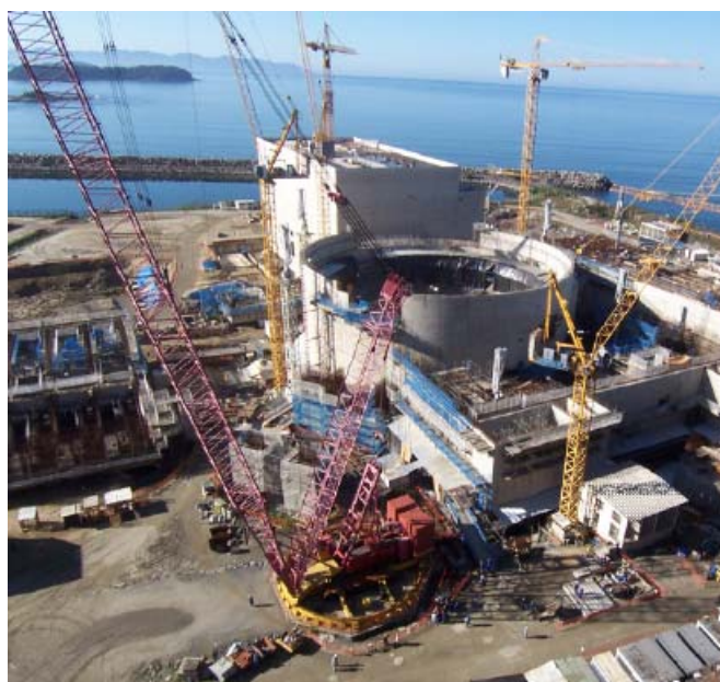
Angra 3 – status de construção do Edifício do Reator (Agosto 2013 - foto Eletronuclear)
