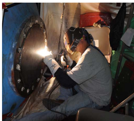
Trabalhador solda um componente do gerador de Vapor em Watts Bar 2 ( foto TVA)
