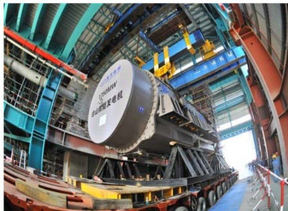
NPP Taishan 1- EPR 1600 em construção
